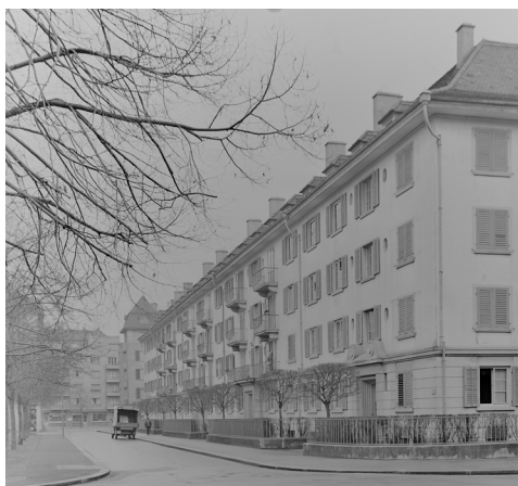
Wohnsiedlung Zurlinden (Bild: Stadtarchiv)
